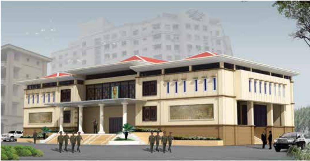
Hội trường Bộ tư lệnh Công binh - 459 Đội Cấn - Hà Nội. Chủ nhiệm đồ án: TS.KTS Lê Chiến Thắng Năm hoàn thành: 2011
