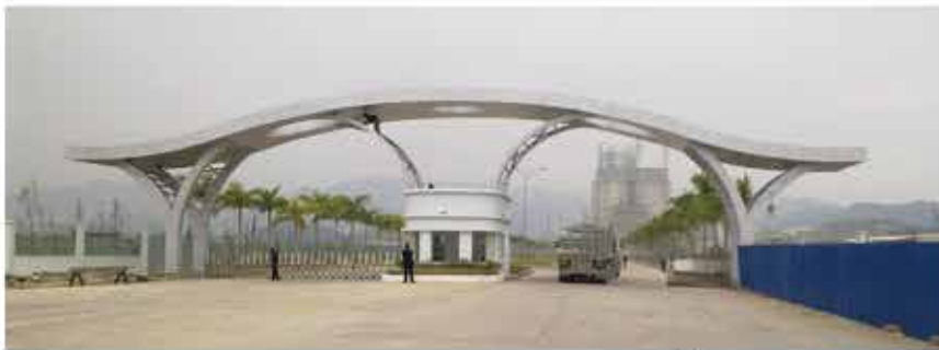
Khu trước nhà máy xi măng Thăng Long - Hoành Bồ - Quảng Ninh Chủ nhiệm đồ án: TS.KTS Lê Chiến Thắng Năm hoàn thành: 2012
